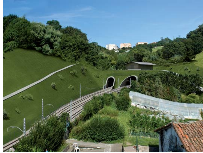
TUNELAREN SARREA LOIOLATIK EMBOQUILLE DEL TÚNEL DESDE LOIOLA
